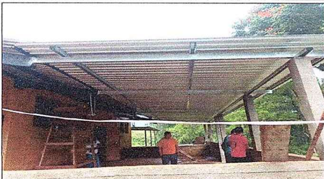
Foto1: Trabajo terminado corredor de la escuela.
