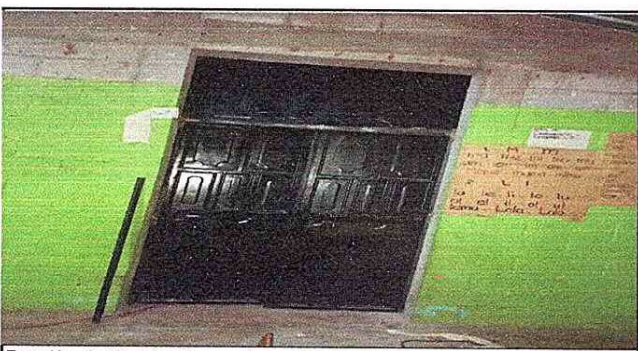
Foto No. 5 : Terminada en colocacion de puertas.
