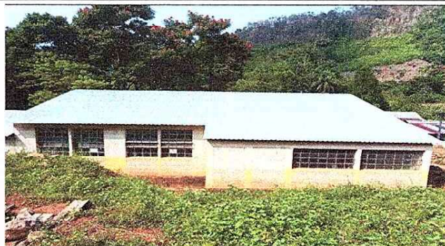
Foto 2: Trabajo de entechado terminado.
