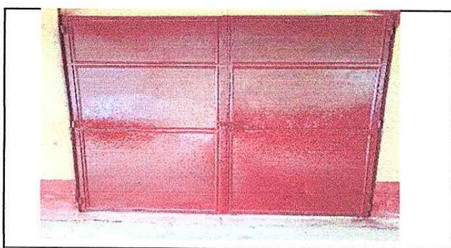
Foto 6 Mantenimiento de puerta terminado.
