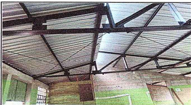
Foto 3: Mantenimiento de estructura terminada.
